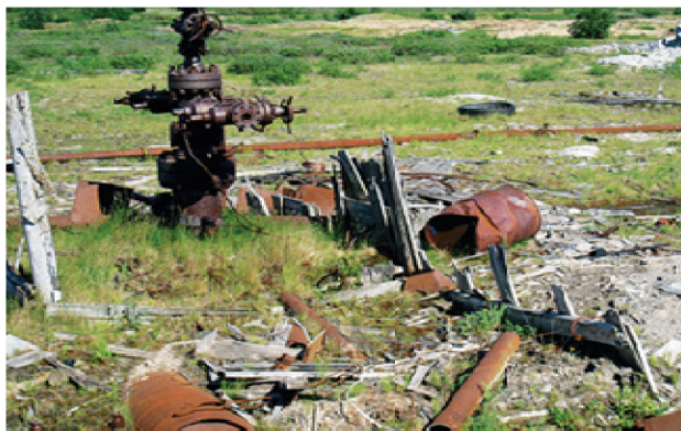
Рисунок-2. Скважина, считающаяся ликвидированной.
