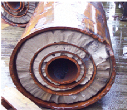
Рисунок-1. Зазоры между колоннами и цементным камнем.
